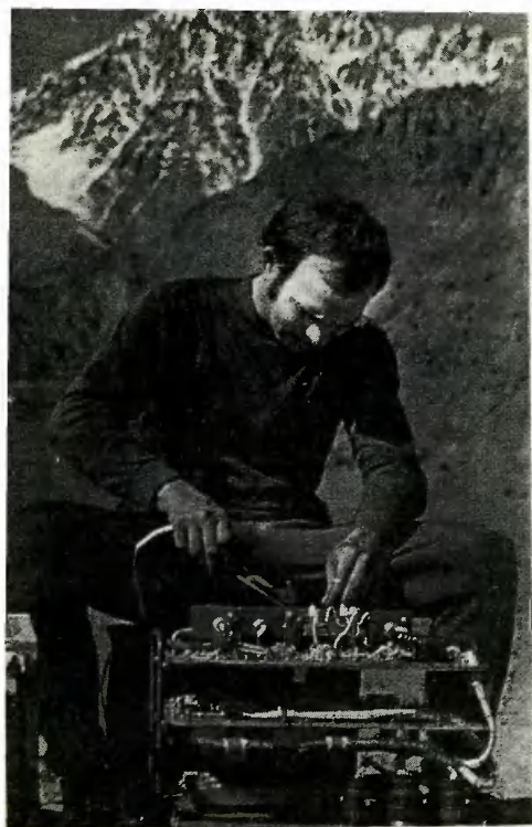
Монтаж идет к концу. Скоро станция примется за работу.
